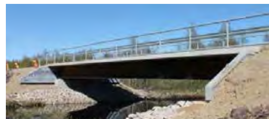
Ruukki Easy Bridge, Jeesiöjoen silta, Kittilä
